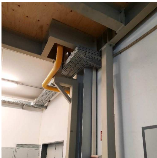
Abbildung 6: Foto Detail Stütze bei Gasleitung
