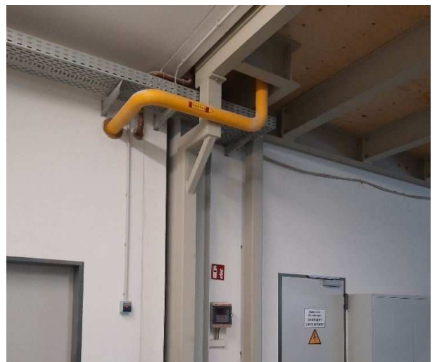
Abbildung 7: Foto Detail Stütze bei Gasleitung
